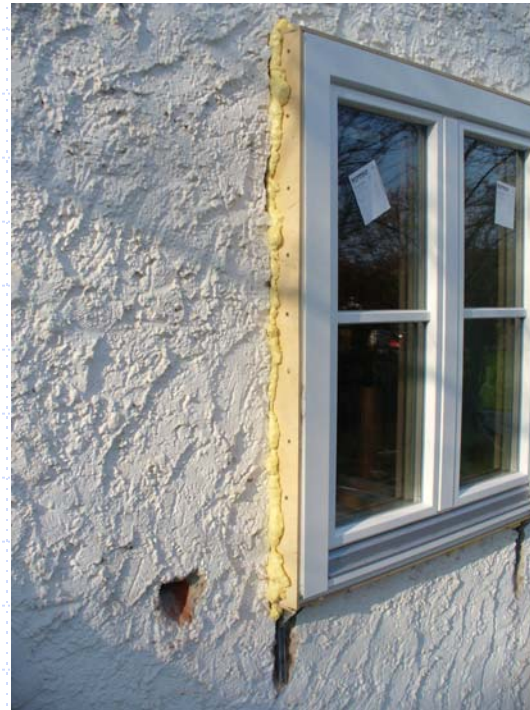
Fenstermontage in Dämmebene...
