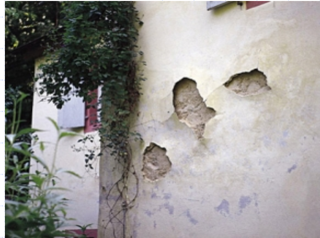
aufsteigende Feuchtigkeit
