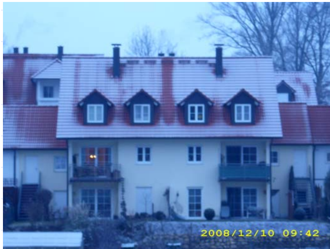
Die Wände und Sparren zeichnen sich ab (Neubau)
