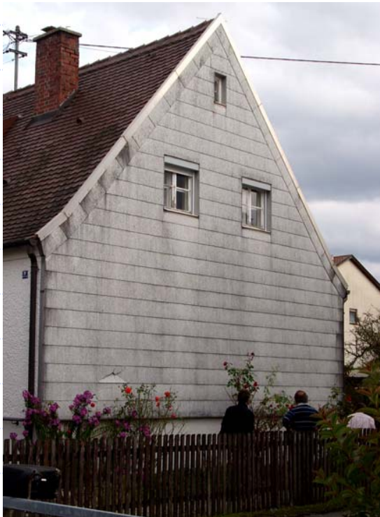
Asbestfassade
