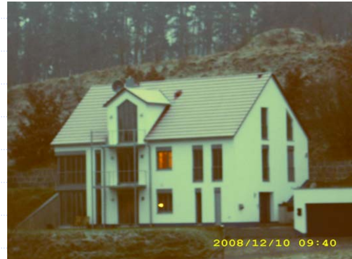
Vorbildliche Dachdämmung (Neubau)
